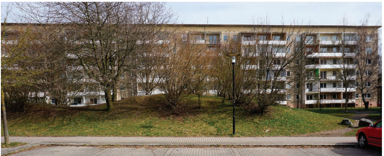
sanierungsbedürftiger Kinderspielplatz inmitten der Wohnbebauung zwischen Göppinger Str. und Erich-Weinert-Str.
