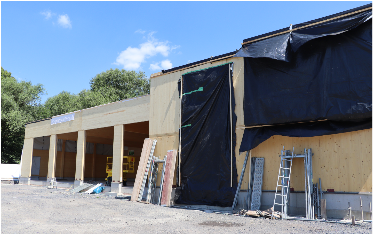
Die Außenkonturen für Fahrzeughalle vorn und Sozialtrakt mit Treppe an der Rückseite stehen bereits. Foto: Stadt Sonneberg/C. Heinkel
