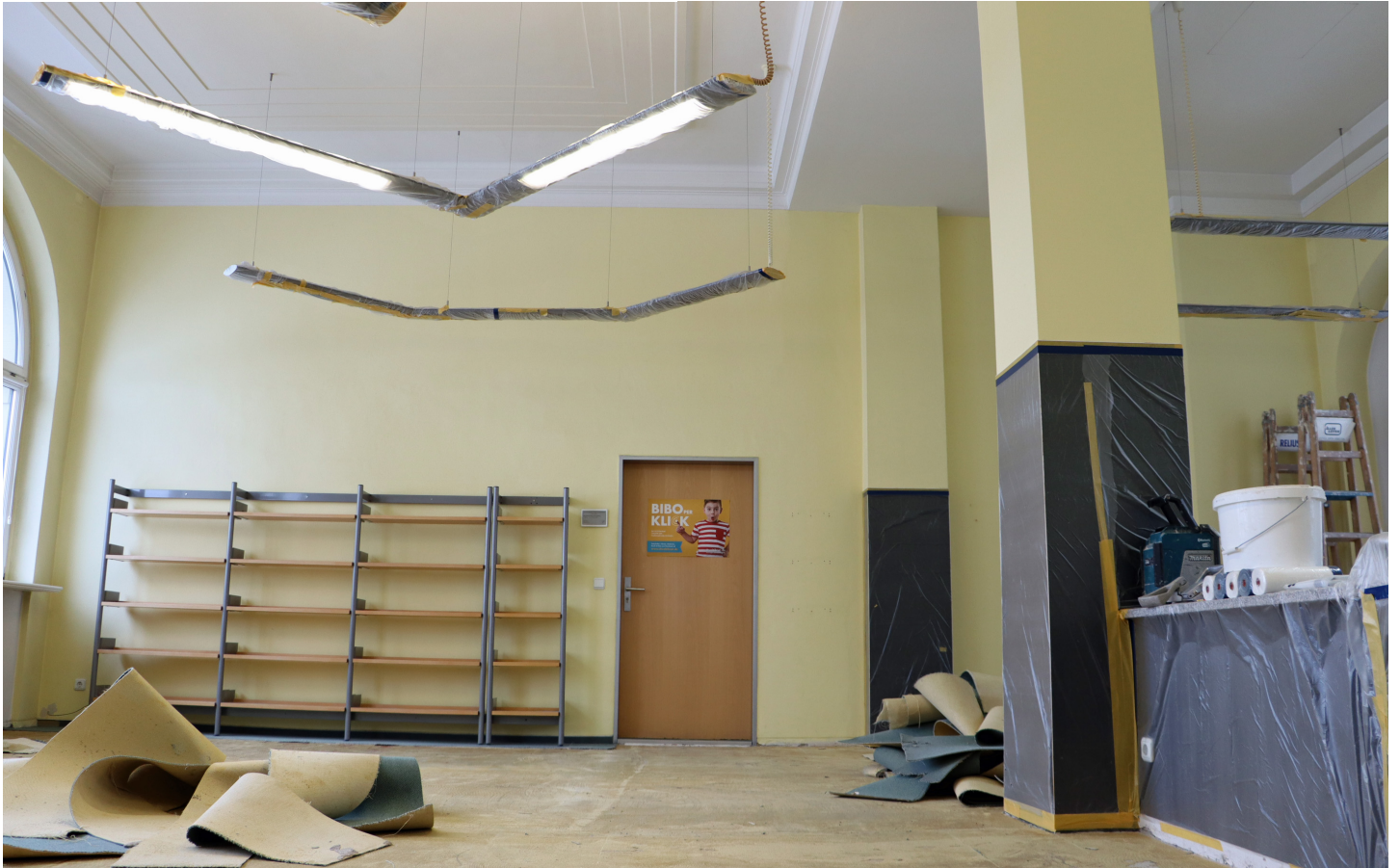
Aus alt mach neu: Die Renovierungsarbeiten in der Stadtbibliothek Sonneberg sind in vollem Gange. Foto: Stadtverwaltung Sonneberg/C. Heinkel
