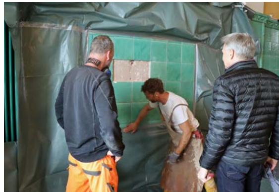
Anfang Juni wurde mit den Umbauarbeiten im Foyer und der Sicherung der Fliesen begonnen. Fotos: Stadt Sonneberg/C. Heinkel
