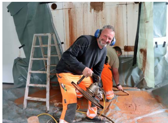
Für den Wanddurchbruch brauchten die Bauhofsarbeiter, hier Frank Walter, schwere Gerätschaften.
