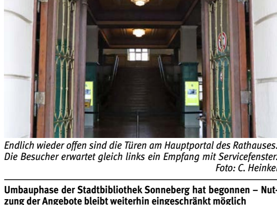
Endlich wieder offen sind die Türen am Hauptportal des Rathauses. Die Besucher erwartet gleich links ein Empfang mit Servicefenster. Foto: C. Heinkel
