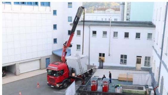
Ein Kran hievt den Elektrolyseur auf den Lkw, um ihn zum nächsten Versuchsaufbau zu transportieren. Foto: Stadt Sonneberg/C. Heinkel
