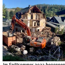
Im Spätsommer 2023 begannen die Abrissarbeiten.
