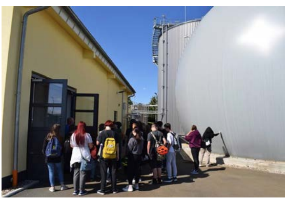
Vorstellung des Klärgasprojektes in der Kläranlage Heubisch.
